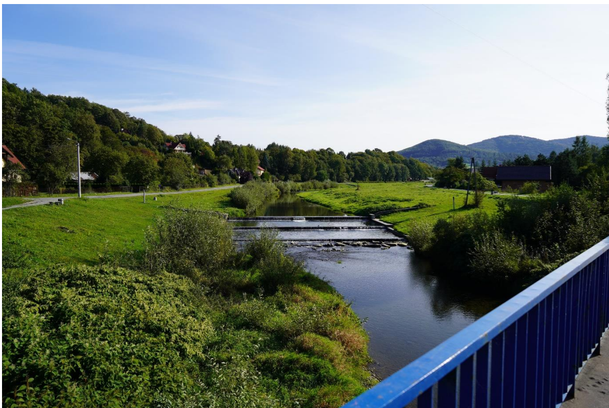
Zdjęcie 3 Rzeka Brenica, widok z mostu na ul. Zofii Kossak w Górkach Wielkich
